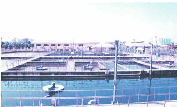
บ่อบำบัดน้ำเสีย จังหวัดนครสวรรค์
